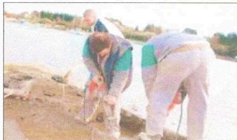
● La société EGC de Ploemeur est chargée du chantier : quatre supports de fixation pour la potence selon les marées. Ci-dessus, l'emplacement le plus bas, à l'extrémité de la cale.
